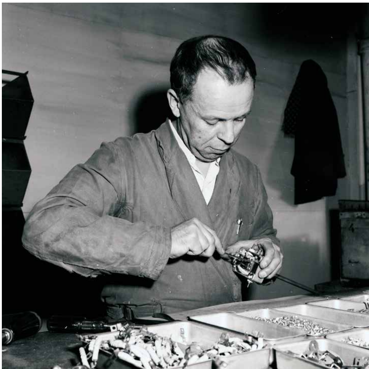
Montering av mindre detaljer och delar före slutmontering. Foto: Olle Englund
